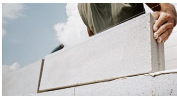
Im Dünnbettverfahren wird nur wenig Mörtel eingesetzt.
