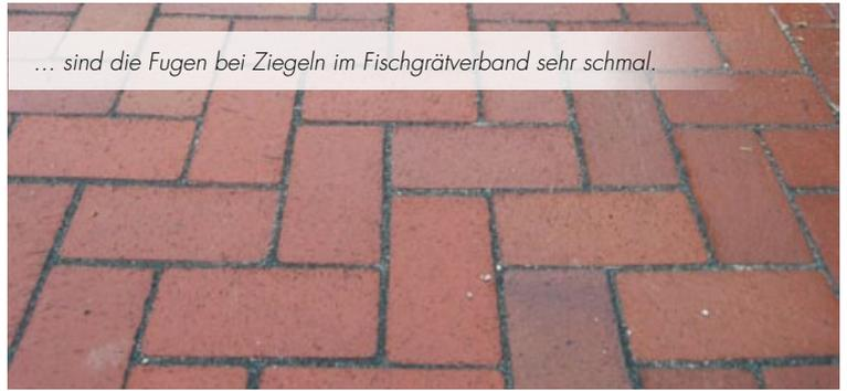
**S**oll die neue Pflasterfläche nicht nur dauerhaft schön und unkrautfrei, sondern auch tragfähig und stabil bleiben, ist eine einfache Sandverfugung nicht ausreichend.
