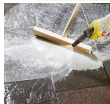
Durch gründliches Wässern mit einem Schlauch oder einer Gießkanne wird der Mörtel in die Fugen geschwemmt.
