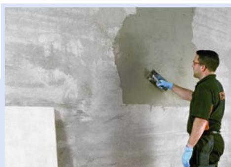
Der Untergrund muss sorgfältig von Unebenheiten wie Fugen, Einschlüssen oder Betonnasen gesäubert werden. Nach der Grundierung wird der Kleber in einer Schichtdicke von 1 bis 5 mm aufgetragen.
