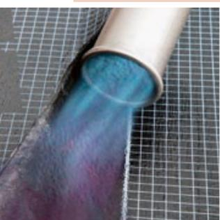
Mit dem Verschweißen des zweiten Teils des Randstreifens ist die Bahn absolut dicht.
