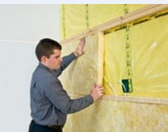
*Einbau einer leichten Trockenbautrennwand: Die mit Mineralwolleplatten ausgefüllten Zwischenräume des Metallständerwerks werden mit Gipskartonplatten beplankt.*
