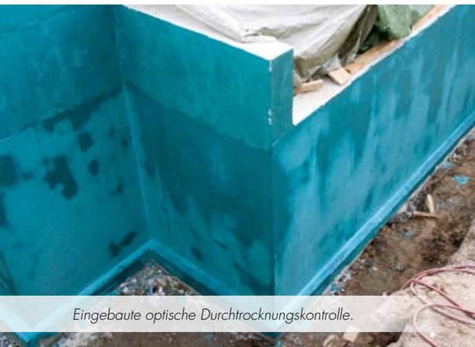
Eingebaute optische Durchrocknungskontrolle.
