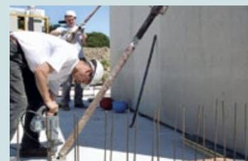
Mit vorproduzierten Betonelementen lassen sich im Handumdrehen ganze Wände, beispielsweise im Kellerbereich, errichten.
