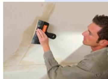
Alle Fugen und Stöße werden mit einer speziellen Spachtelmasse verfüllt.
