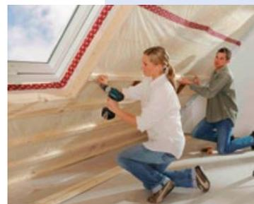
Vorbereitung für den Einbau einer zusätzlichen, quer liegenden Dämstofflage.
