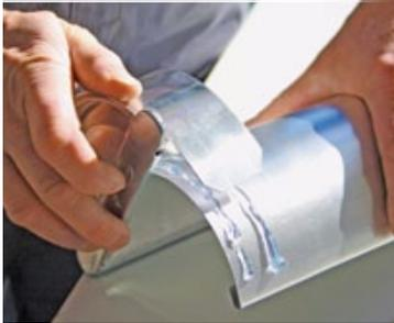
Die Verbindung zweier Alu-Dachrinnen erfolgt mittels spezieller Rinnenverbinder; für den fachgerechten Abschluss stehen passende Rinnenendstücke zur Verfügung. Der Vorteil im Gegensatz zu beispielsweise Kupferdachrinnen (die gelötet wer-
