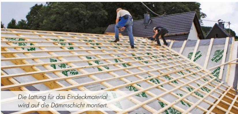
Die Lattung für das Eindeckmaterial wird auf die Dämmschicht montiert.
