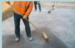
**2.** Gleichmäßige Verteilung auf dem trockenen Belag. Das Material wird mit kreisenden Kehr-bewegungen langsam in die Fugen eingearbeitet.
