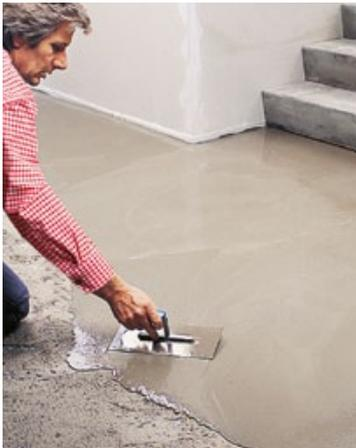
Mit der fließfähigen Ausgleichsmasse Fließt & Fertig lassen sich perfekt ebene Untergründe erstellen.
