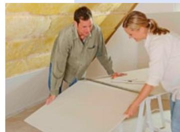
Gipsfaserplatten lassen sich mühelos brechen, nachdem sie mit einem Cuttermesser angeritzt worden sind.
