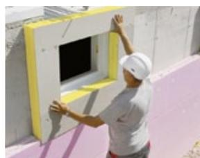
*MEAFIX ermöglicht die Lichtschachtmontage ohne Fehler beim Messen und Bohren: einfach an die Wand kleben, Perimeterabdeckrahmen montieren und Lichtschacht einhängen.*
