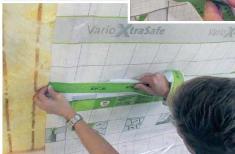
Dank Klettfunktion lässt sich die „Vario XtraSafe“ Klimamembran wieder abziehen und problemlos nachjustieren. Diese Befestigungsart erspart die Tackering und verhindert eine Verletzung der Folie.
