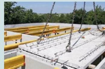
Bei Fertigteildecken entfällt beispielsweise das zeitintensive Einschalen auf der Baustelle.
