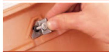
Die Stormfix-Klammer wird in die Vertiefung des Ziegels eingesetzt ...
