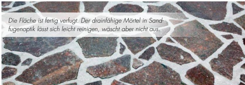
Die Fläche ist fertig verfugt. Der drainfähige Mörtel in Sandfugenoptik lässt sich leicht reinigen, wäscht aber nicht aus.
