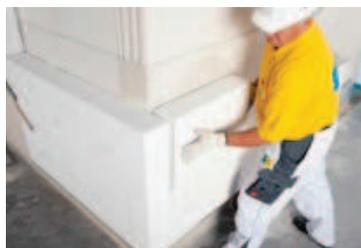
Bei Bauvorhaben, bei denen aus verschiedenen Gründen kein WDVS ausgeführt werden kann, kann das Multipor Innendämm-System die gewünschte Wärmedämmung erzielen.
