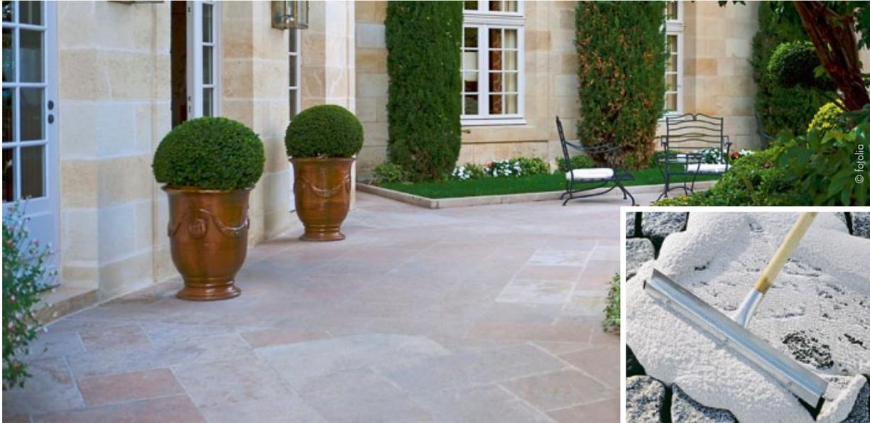
Der angemischte Pflasterfugenmörtel wird mit einem Schieber in die Fugen eingearbeitet.
