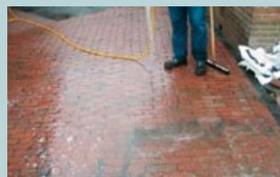
**5.** Benetzung der gesamten Oberfläche mit weichem Wasserstrahl bis zur vollständigen Sättigung aller Fugen.
