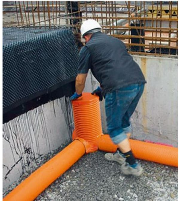
*Unterirdisch eindringende Feuchtigkeit bedroht die Bausubstanz auch über der Erde: Aufgrund der Kapillarwirkung der Wandbaustoffe wird Wasser regelrecht nach oben gesaugt. Ein Gebäudedrängungs-system verhindert, dass sich die Nässe unnötig lange vor den Wänden staut.*
