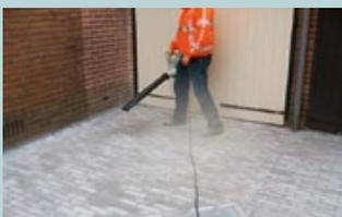
**4.** LITHOSAND nachfüllen und überschüssiges Material sorgfältig entfernen. Porige oder offene Steine besonders sorgfältig (Laubbläser oder Staubsauger) reinigen.
