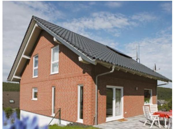
*WDVS oder Stein-auf-Stein? Eine mit Riemchen verkleidete Hausfassade ist auch auf den zweiten Blick nicht von einem Gebäude zu unterscheiden, das komplett mit Verblendklinkern vermauert wurde.*
