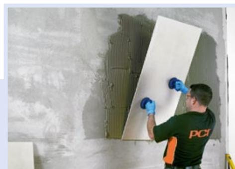
Das Kleberbett wird mit einem Zahnpachtel gekämmt, die großformatige Fliese positioniert und angedrückt. Dank der hohen Standfestigkeit werden auch schwere Platten sicher in Position gehalten.
